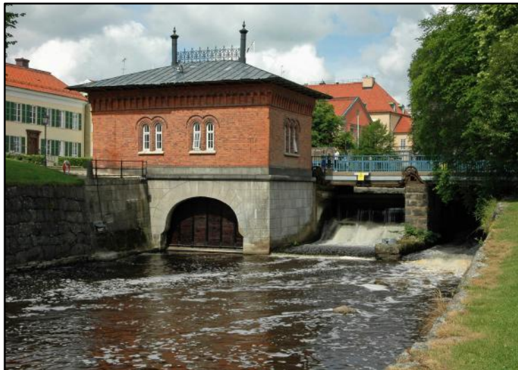
Turbinhuset som byggdes 1891 för att locka ASEA till Västerås. Stor vikt lades på utseendet skulle smälta in i den befintliga stadsmiljön runt Västerås slott. I drift igen sedan 1995.
