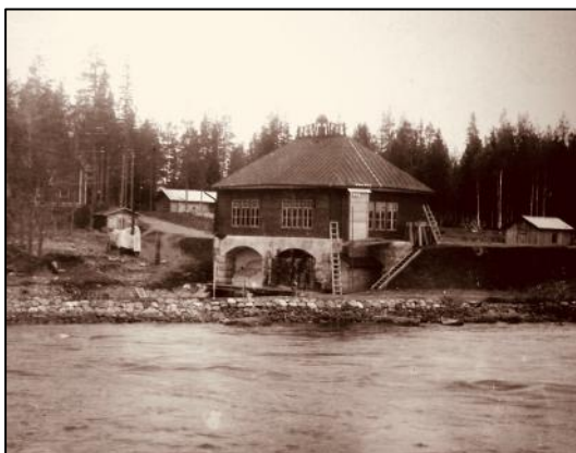
Ovan två fotografier är Lövöns kraftstation vid Strömsund som byggdes 1904 för två maskinaggregat t.v. och uppgraderades 1916-17 till tre, t.h., av bland annat Per Martin när han 1916-19 arbetade för Asea i Östersund .
