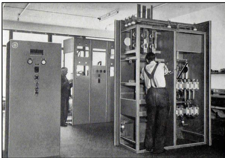
Montage av inomhusställverk samt kopplings- och instrumenttavlor skedde i IA:s verkstad i Stockholm
